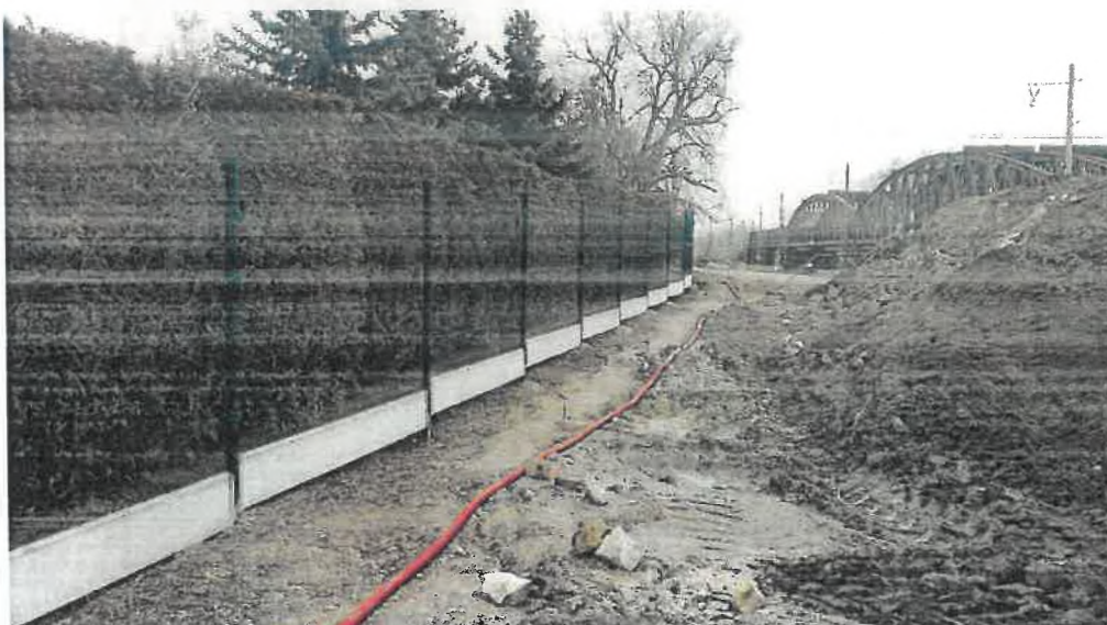
Po obnově - plot ze svařovaných sítí s PVC úpravou
