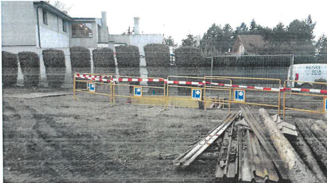
Po demolici, včetně provizorního oplocení
