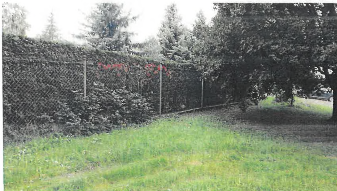
Před stavbou - plot z pletiva
