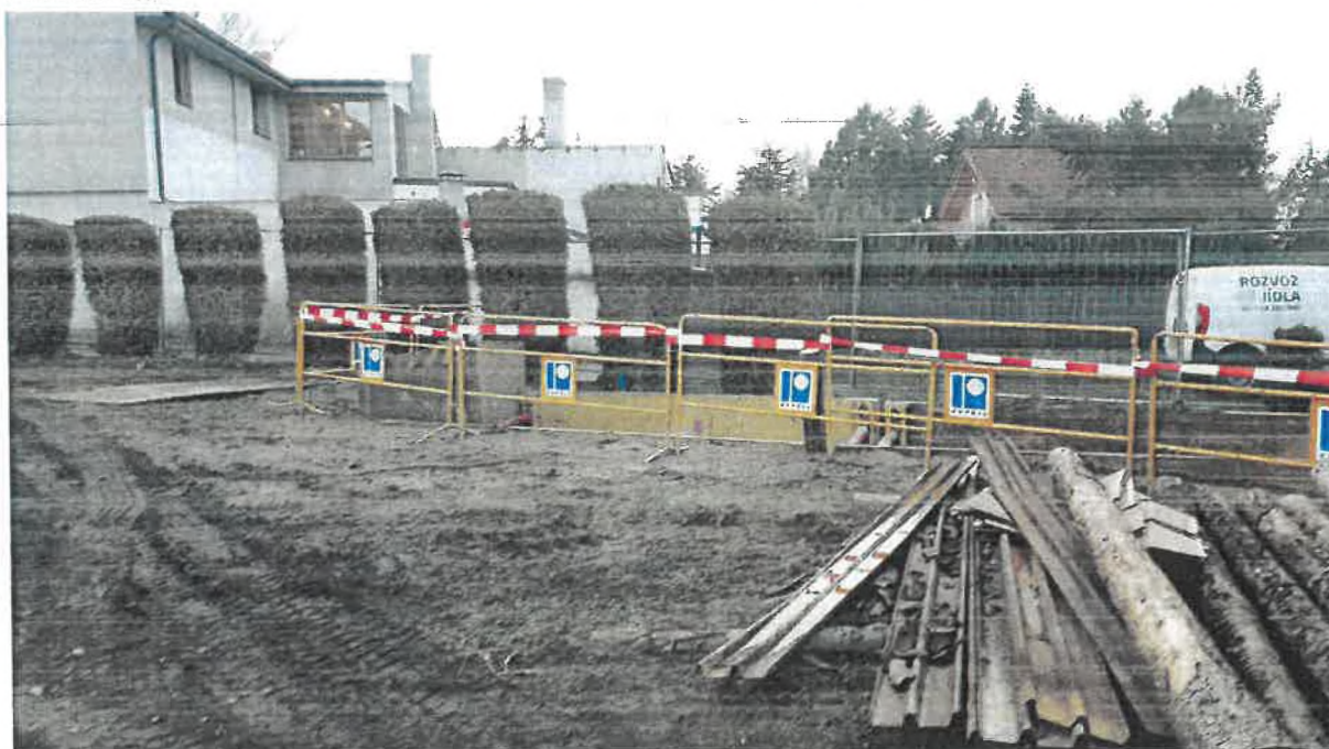
Po demolici, včetně provizorního oplocení
